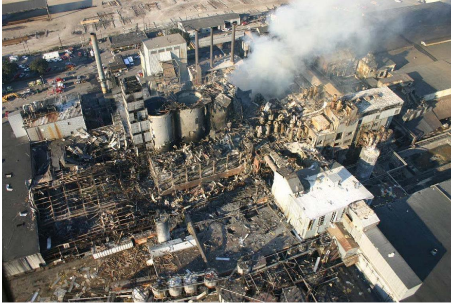
Rys.1. Skutki wybuchu pyłu cukrowego w Imperial Sugar Company w 2008 roku [3]
