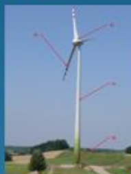
Rysunek 1. Elektrownia wiatrowa: a) gondola; b) łopata turbiny; c) wieża; d) wejście.
