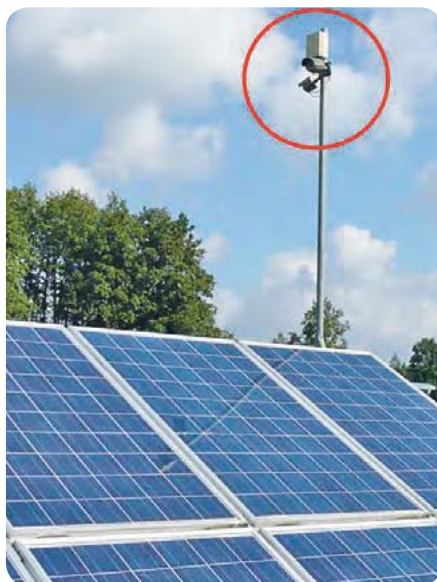
Fot. 5. Kamera wizyjnego systemu nadzoru elektrowni fotowoltaicznej
