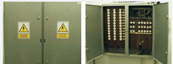
Fot. 6. Przykład obudowy – otwarcie za pomocą klucza lub narzędzia
