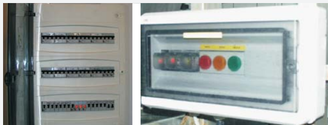
Fot. 5. Przykłady obudów, których otwarcie jest możliwe bez klucza (narzędzia) i bez odłączenia napięcia
