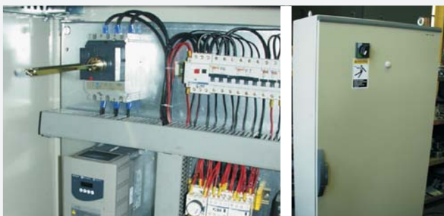
Fot. 7. Przykład obudowy – otwarcie możliwe po odłączeniu części czynnych znajdujących się wewnątrz
