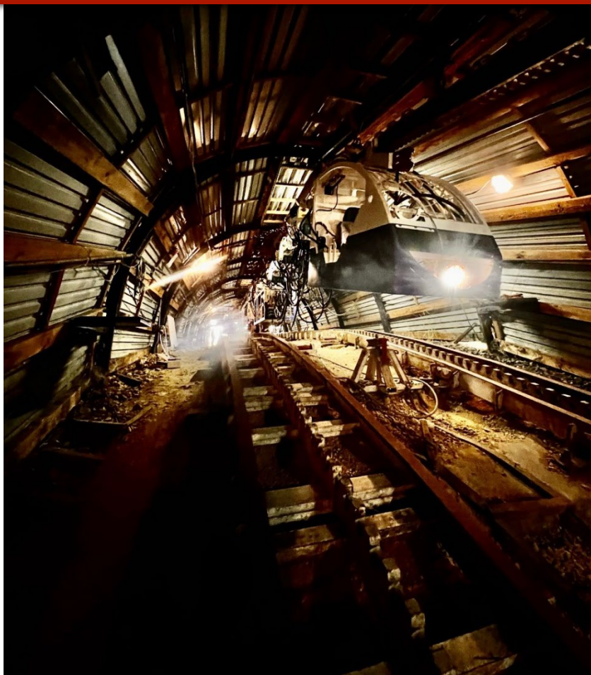
Fot. Testowanie kolejki podwieszanej w wyrobisku górnicy (fot. własna)
